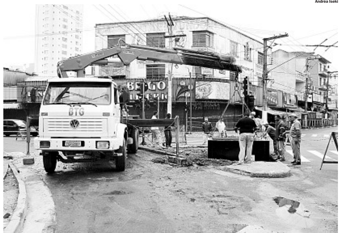
Trecho terá colocação de postos de inspeção e cabine de transformadores de energia para fiação elétrica e telefônica
